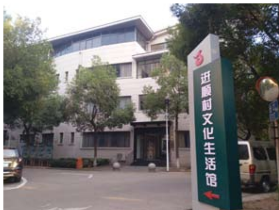
① 新建成的进顺村文化生活馆
