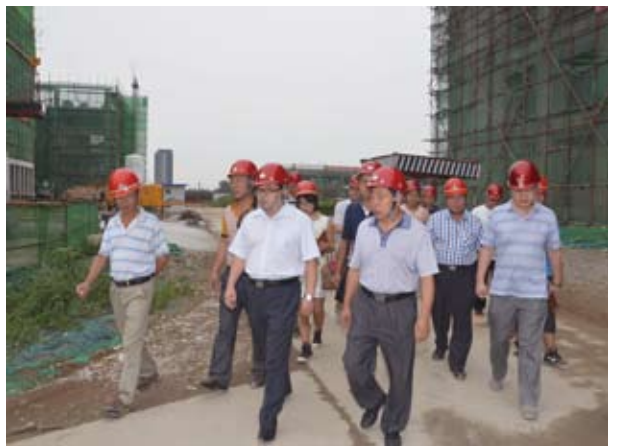
④ 检查建筑工地
