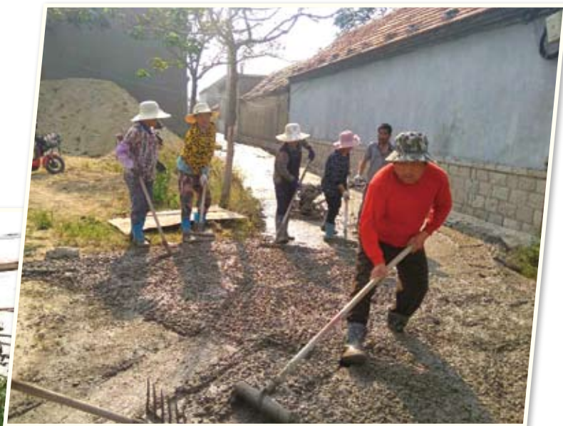
❷ 修建道路
