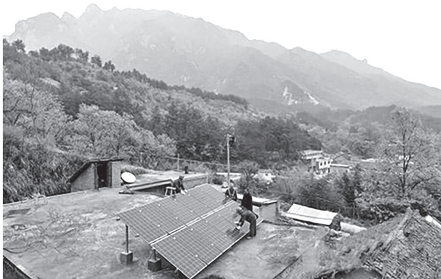
技术人员在贫困户屋顶建设户用光伏扶贫电站
